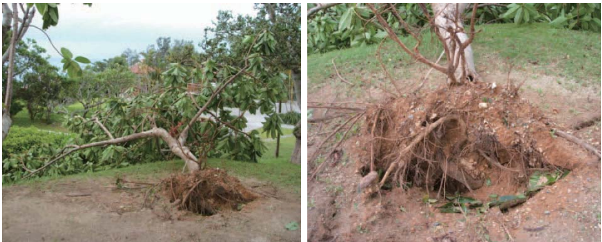
写真-1.29 植栽基盤の整備不良により根系伸長が少ない倒木(インドゴムノキ)
