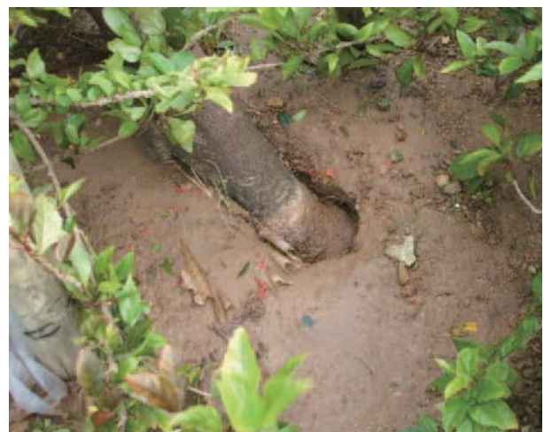
写真-1.11 雨水により軟弱化した土壌
