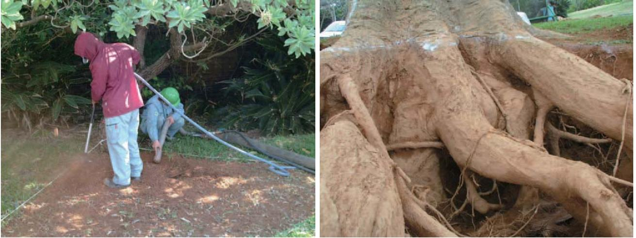
写真-IV.2 圧縮空気による土壌掘削
