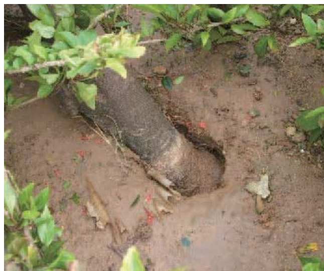
写真 - I .1 雨水を含んで緩んだ土壌
