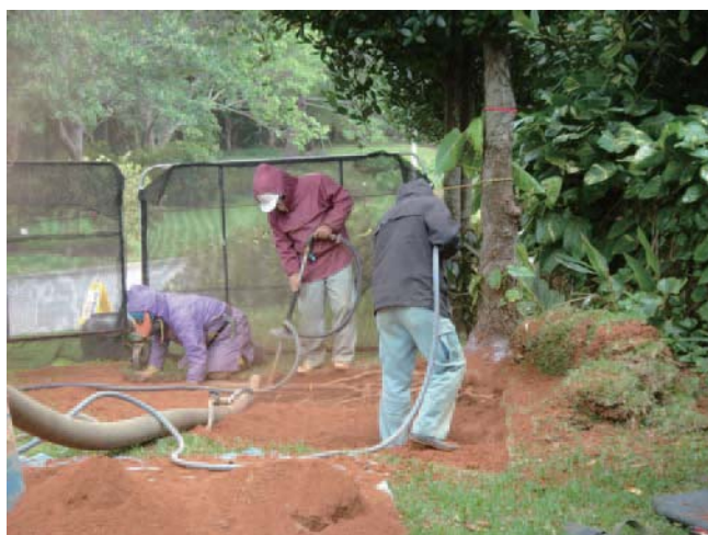
写真-2.2 水平方向の土壌掘削
