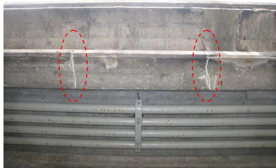
写真 2.3.4 ひび割れ状況（下面）
