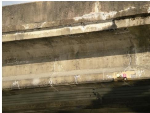
写真 2.3.8 ひび割れ状況 (G7 桁)
