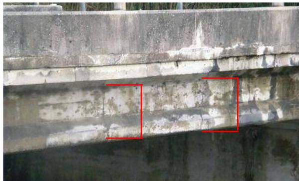
写真 2.3.13 G7 桁に確認されたひび割れ
