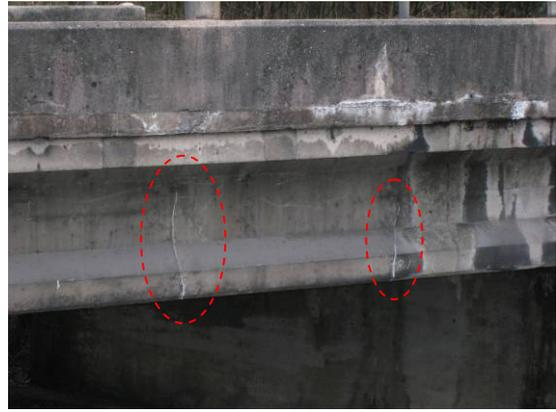
写真 2.3.2 ひび割れ状況（側面）
