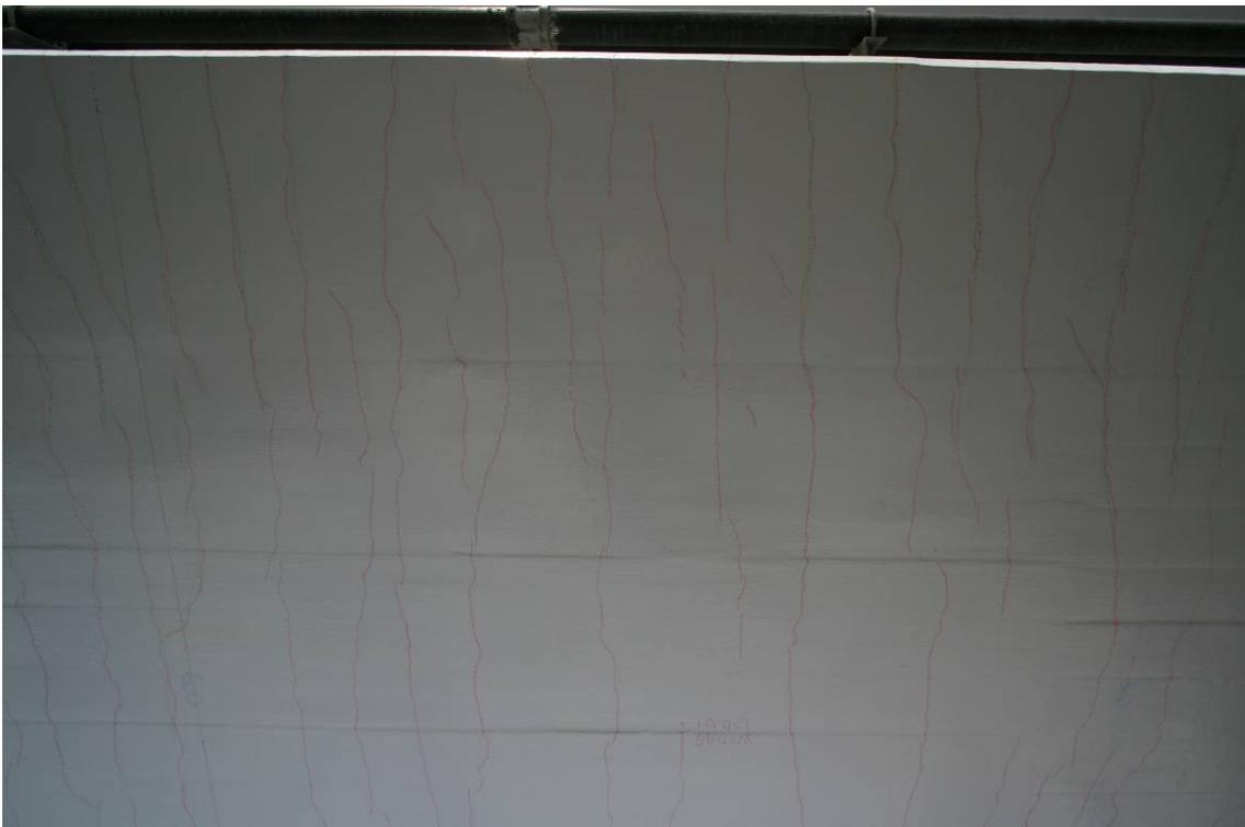
写真 2. 2. 3 主桁下面ひび割れ状況
