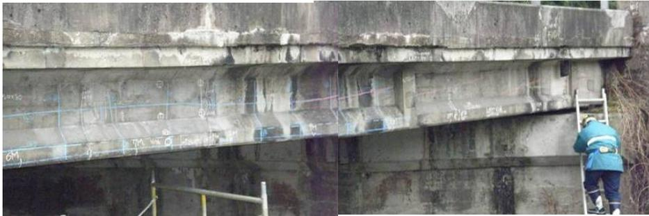
写真 2.3.14 ケーブル配置 (G7 桁 A2 側)
