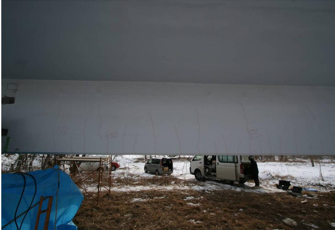
写真 2. 2. 2 主桁側面ひび割れ状況
