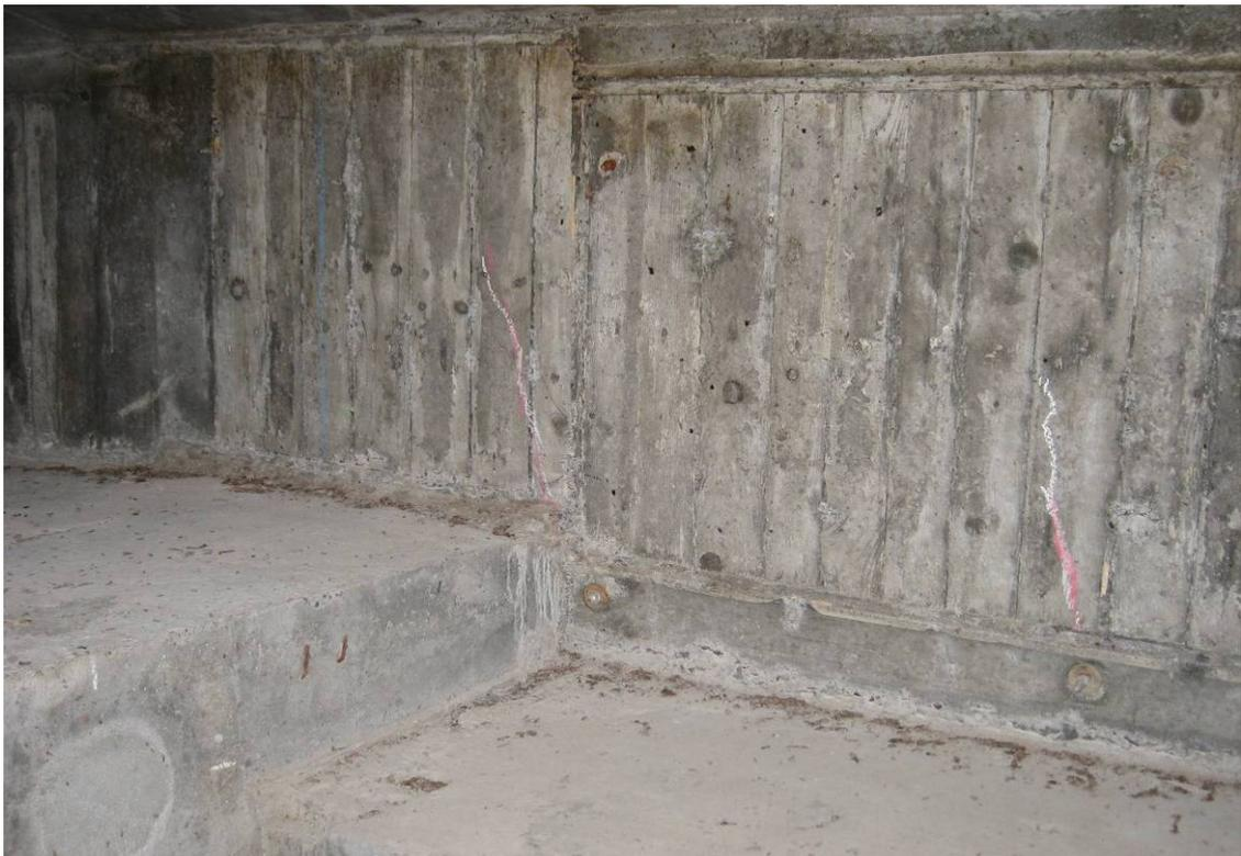
写真 2.2.4 ウェブ内面（箱桁内部）ひび割れ状況
