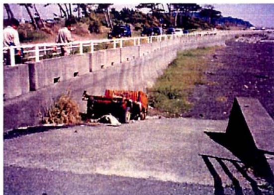
写真 3.1.23 放置トラックの事例（静岡県）
