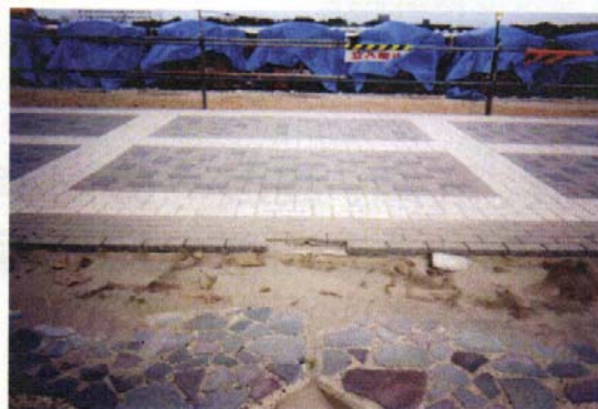
写真 3.1.19 車両の乗り入れによる損傷状況
