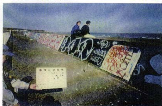
写真 3.1.20 護岸パラペットのペンキ書き
