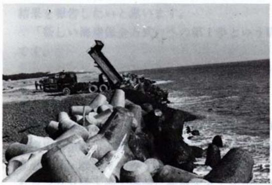
写真 2.3.6 消波堤前面に投入されるバイパスされた土砂（駿河海岸）
