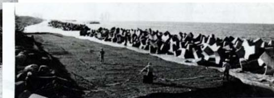
写真 2.3.8 土砂投入状況 (横尾地先)
