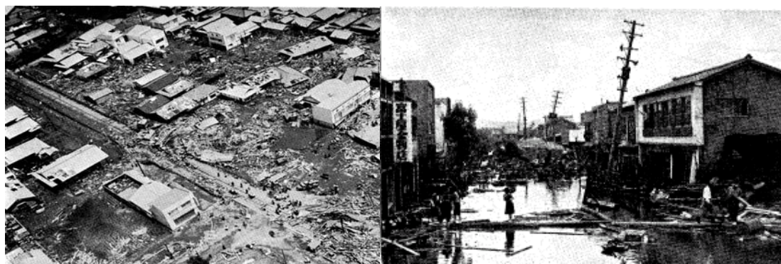
写真 1.4.3 チリ地震津波による被災状況（岩手県）
