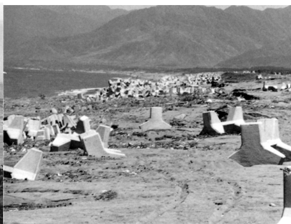
写真 1.4.5 秋田県峰浜海岸消波堤散乱状況
