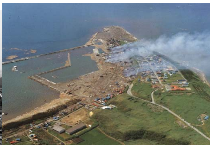
写真 1.4.7 奥尻島青苗地区被災全景
