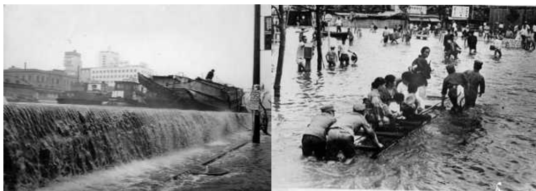
写真 1.4.2 第二室戸台風による被災状況（大阪府）
