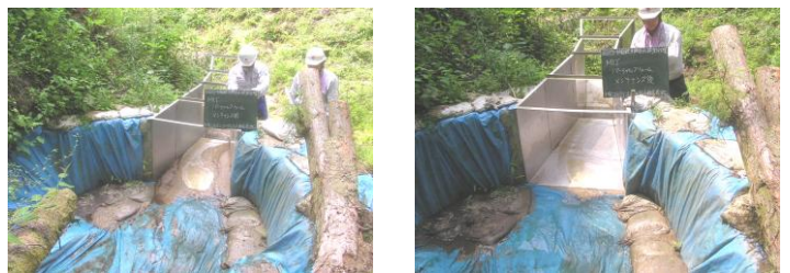
作業前 作業後 図-3 点検作業写真
