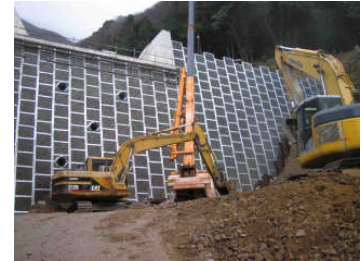
クレーン打設の状況
