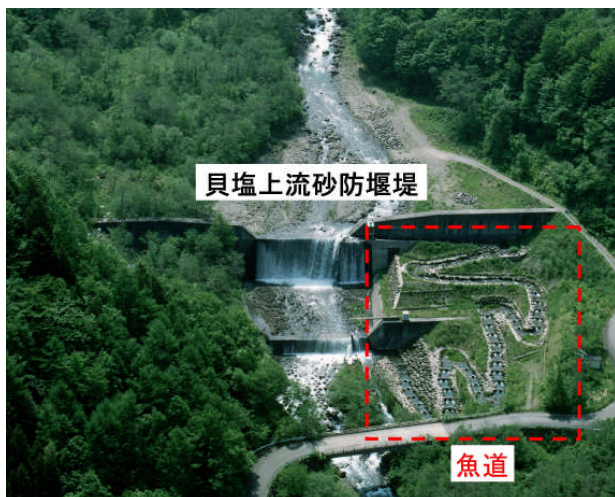
(写真-1) 魚道を設置した砂防堰堤
