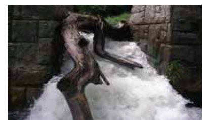
写真 スリット部への流れの集中
