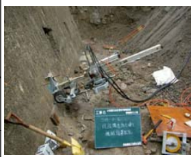
3. ワイヤソーによる切断
