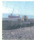
●河川等の堆積土砂を利用した養浜
