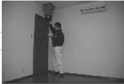
図10 風量測定器を用いた測定状況
