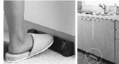
図 19 足元止水スイッチの例
