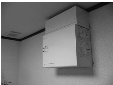
図4 壁設置の換気装置
