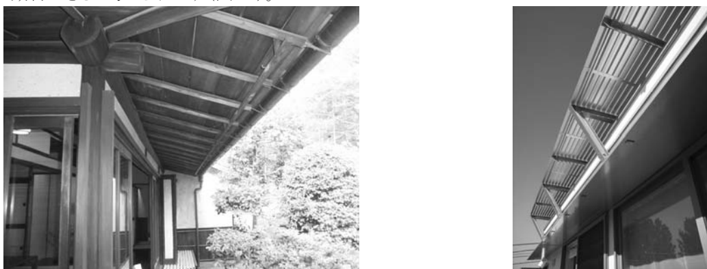
図17 庇等を利用した日射遮蔽の例
