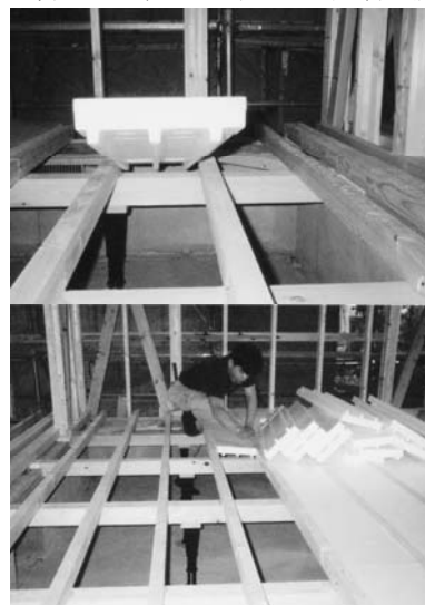
図 34 ボード状断熱材の施工状況
