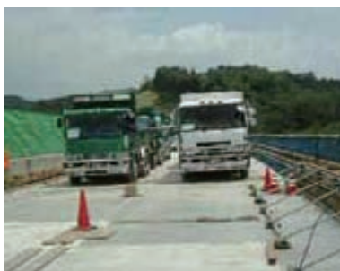
図 6.2.6 載荷試験状況
