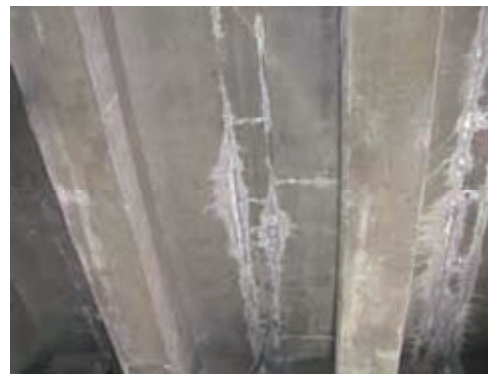
写真 2.4.8 間詰め部の漏水
