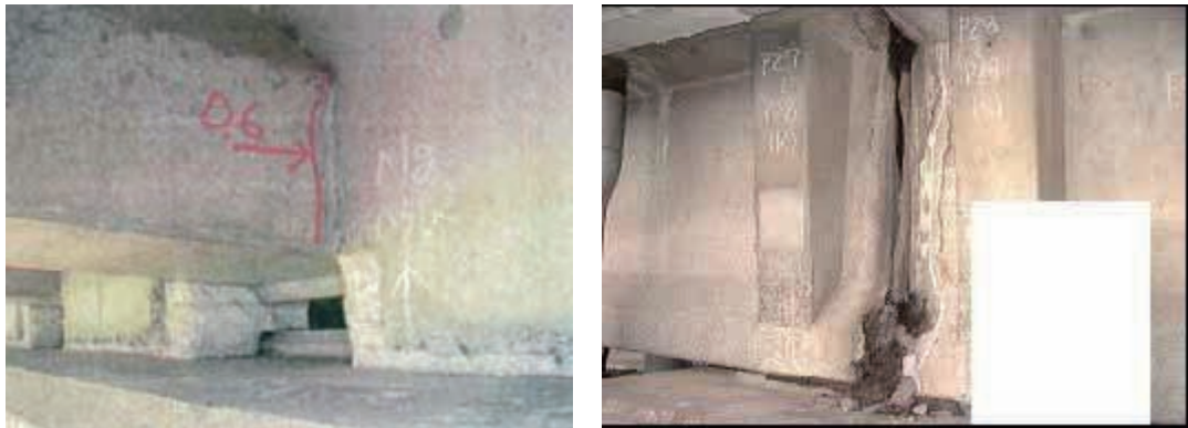
写真 2.4.4 PC 主げた桁端部近傍の鉛直ひび割れ
