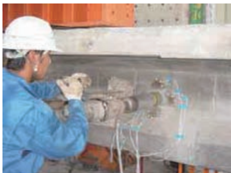
写真 2.4.14 応力解放法実施状況
