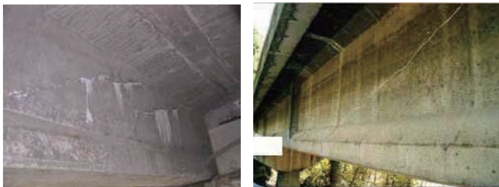
写真 2.4.6 PC 鋼材に沿ったひび割れ
