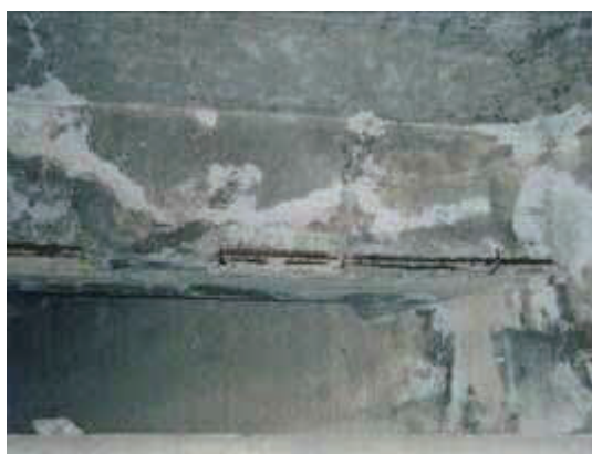
写真 2.4.5 コンクリートの剥落、鋼材の腐食・露出
