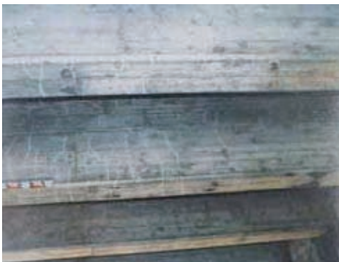
写真 2.4.7 支間中央部のひび割れ
