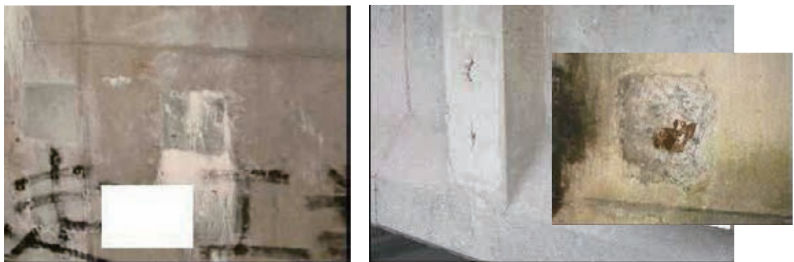
写真 2.4.12 PC 定着部の後埋め部からの遊離石灰、後埋め部の剥離
