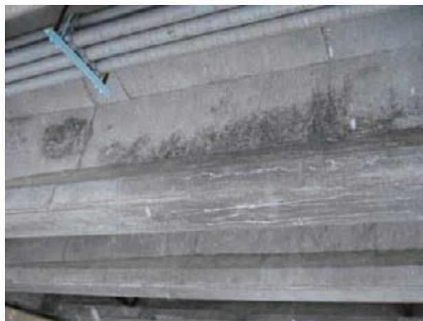
写真 2.4.1 PC主げた下面の縦方向のひび割れ
