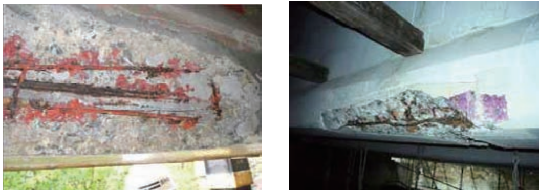
写真 2.4.11 PC 鋼材の腐食, 破断
