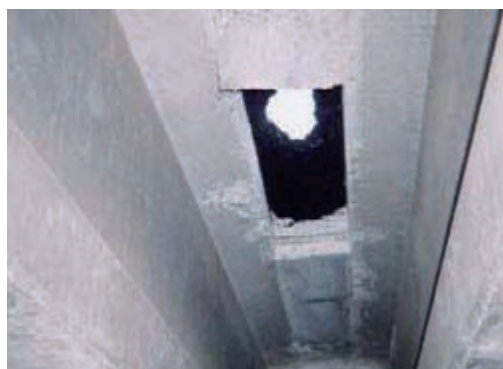
写真 2.4.9 間詰め床版の抜け落ち
