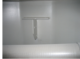
2) 対傾構 (形状保持金具) 取付用箱桁内
