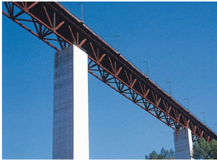
写真-2.1.2 下横構を簡素化した上路トラス (シングルワーレントラス)
