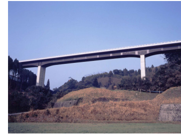
少数鋼桁の複合ラーメン橋 （今別府川橋）
