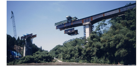
張出し架設状況
