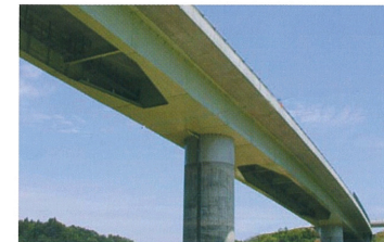
パーシャル箱桁（部分箱桁）の 複合ラーメン橋（下浜點川橋）
