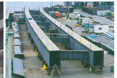
主げた仮組状況 (猿渡川橋)
