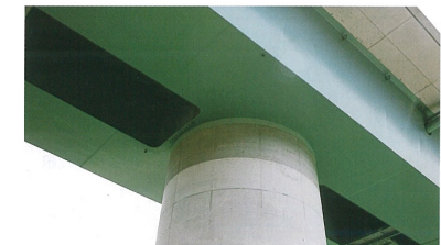
2箱桁の複合ラーメン橋 （横浜青葉IC）
