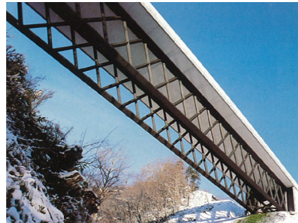
写真-2.1.3 上横構、下横構、対傾構を省略した上路トラス
