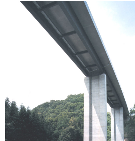
写真-2.1.1 少数鉸桁での横構省略・横げた簡略化構造
