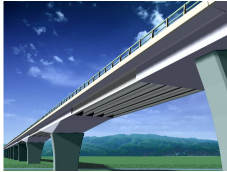
図-1.3.1 プレキャスト桁を用いた PC 構造
