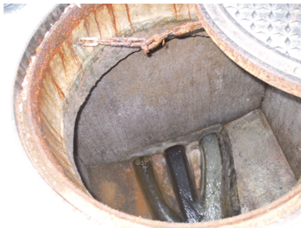
写真-3.1 汚水柵の状況 ※複数の別系統管が複数流入
