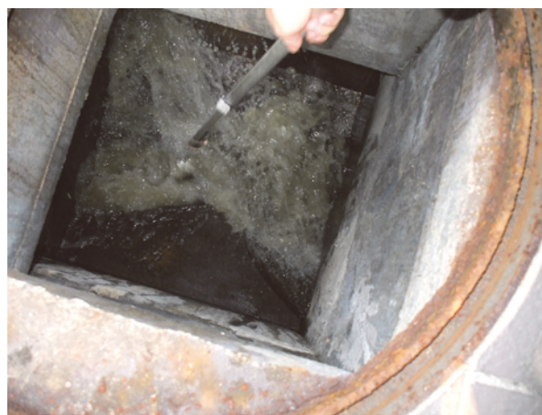
写真-3.2 ポンプ作動時の汚水柵の状況 ※汚水柵内で激しく流下。下水のサンプリングも困難。
