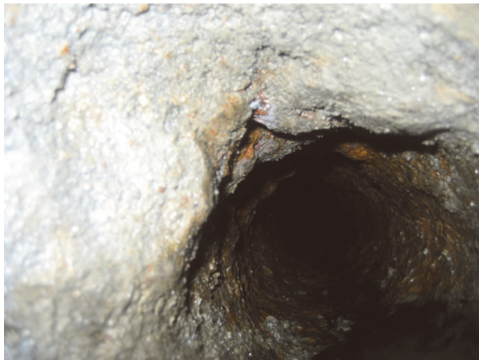
写真-3.3 取付管の腐食状況 ※手前のコンクリートは汚水柵壁面
