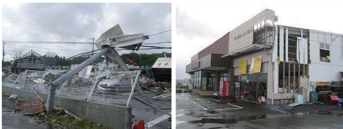
図 I-4-5 竜巻による被害状況
