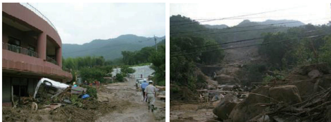
図 I-4-6 土石流による被害状況
