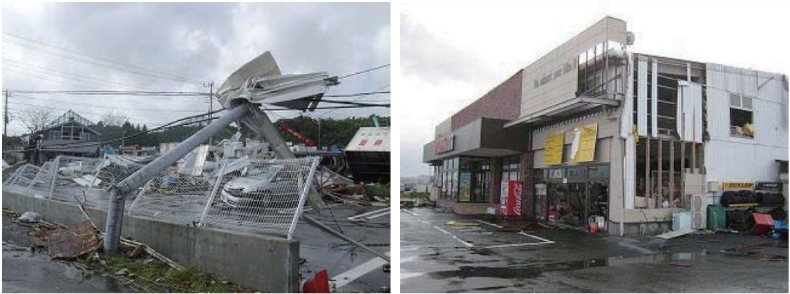
図 I-4-5 竜巻による被害状況
