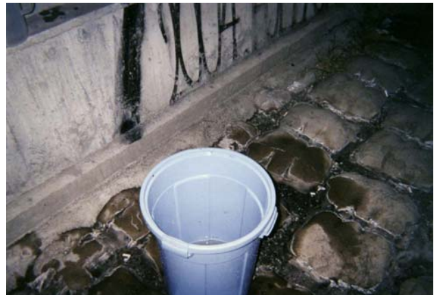
【路面排水の採水状況】
