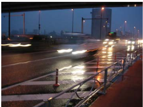
②国道高架下路面状況 (平坦地点)
