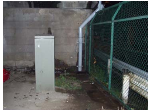
路面排水採水地点 (遠景)
