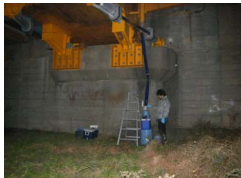
②国道高架下路面状況 (平坦地点)
