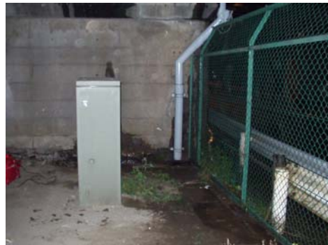
①国道左岸路面排水採水地点 (遠景)
