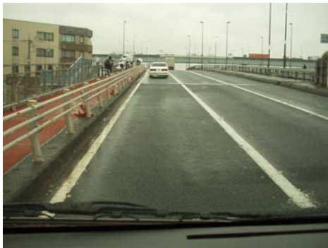
①国道左岸路面状況 (上り坂車線)
