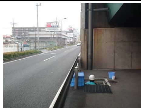
路面排水採水地点（遠景）
