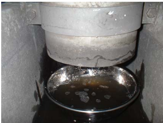
写真 3.1 雨水管の流出状況 (1回目調査)
