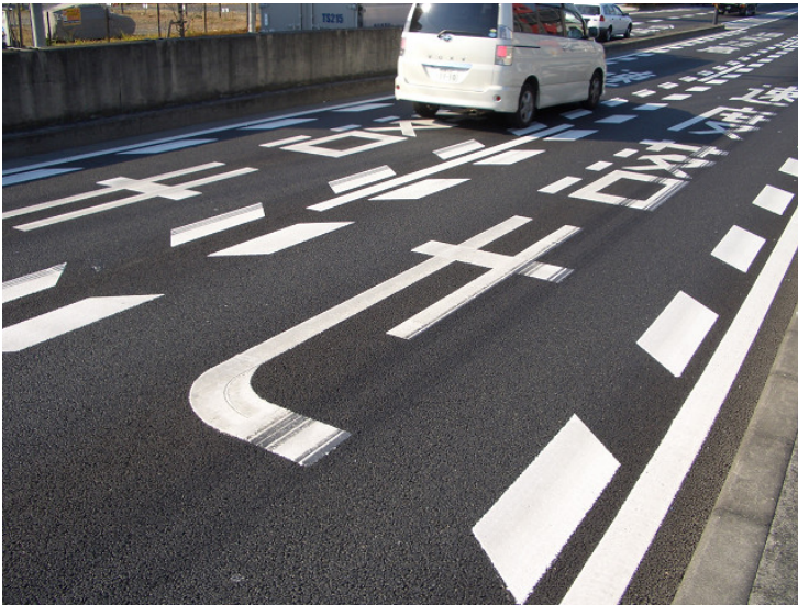
現地は下り坂の急ブレーキ区間で、路面には多数のブレーキ痕が見られた
