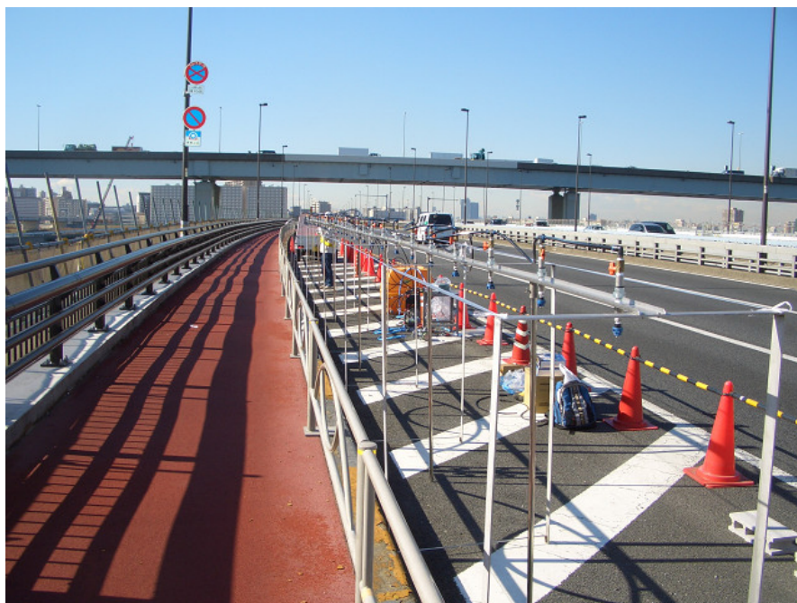
写真 6.1 散水装置組み立て状況①
