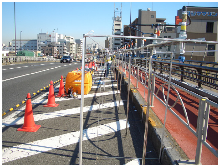
写真 6.2 散水装置組み立て状況②
