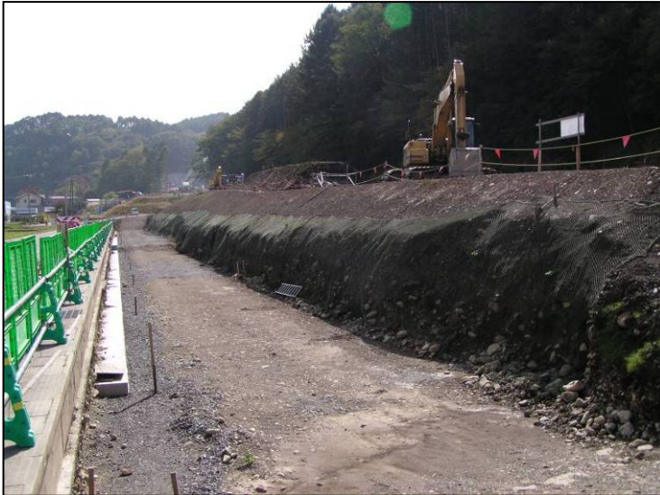
1) 盛土部を段階的に施工し、速やかに転圧している例
