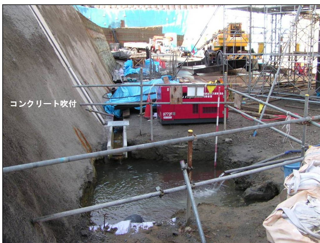
4) その他、写真の左側の法面にコンクリートを吹付けて、濁りを発生させない例
