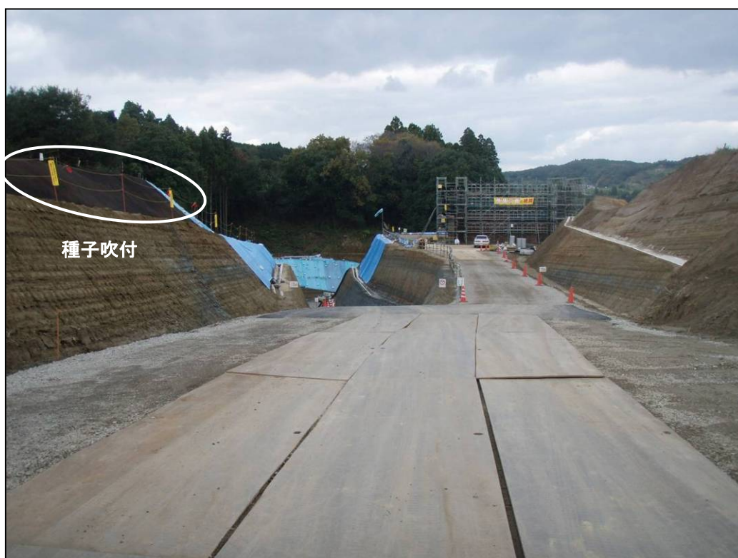
3) 写真の左上に種子吹付を行い、速やかに植生による被覆を行う例
