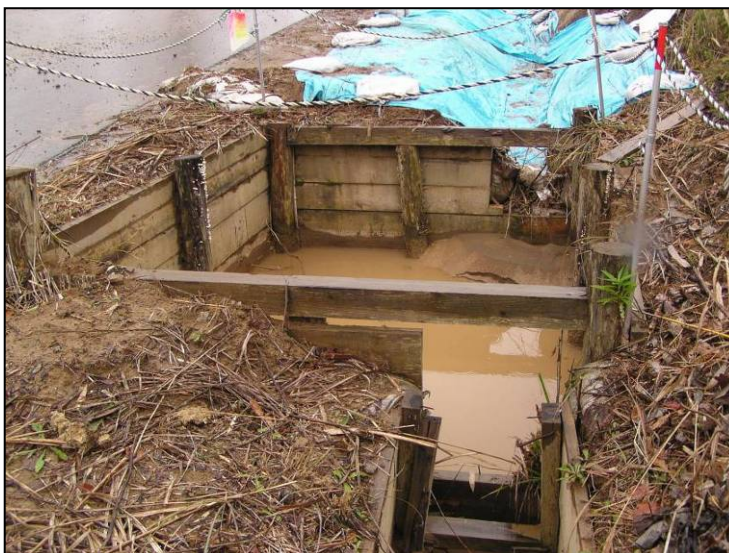
2) 1) の仮設沈砂枡を下流側から上流側に撮影している
