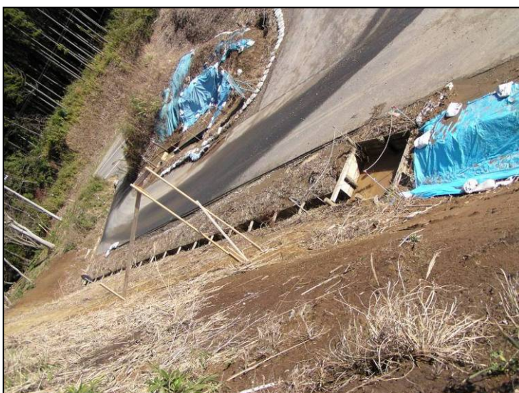
3) 1)、2) の仮設沈砂枡を、法肩から法尻の方向に撮影している
