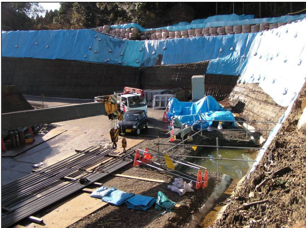
施工箇所へのシート張りによる法面保護の例
