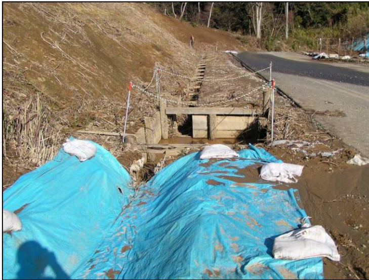
1) 仮設沈砂枡を上流側から下流側に撮影している
