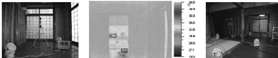
写真 2 1階廊下間仕切壁表面温度分布(改修前:室内 20.3°C、外気 7.8°C、改修後:室内 32.3°C、外気 9.3°C)
