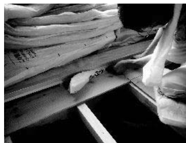
図 16 ●荒板と敷居の間に気流止めを充填
