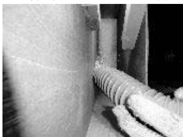
図 11 壁体内へ EPS を吹き込む様子
