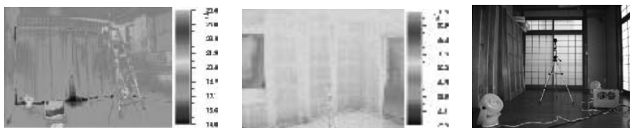
写真 1 1階南東隅角表面温度分布(改修前:室内 20.3°C、外気 7.8°C、改修後:室内 32.3°C、外気 9.3°C)
