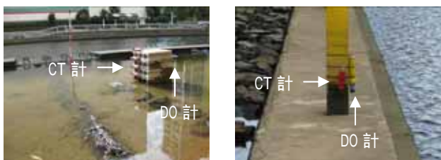
写真-9 機器設置状況
