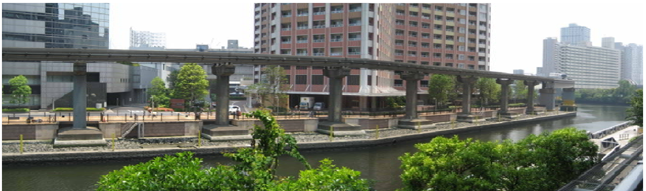
写真-4 テラス型護岸全景
