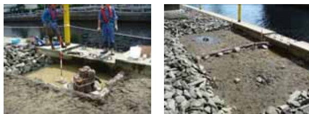
写真-16 粗朶の設置状況(左:A池,右:B池)
