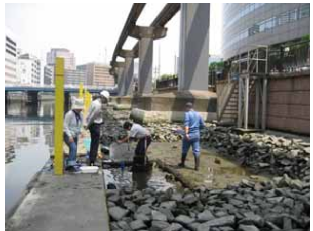
写真-3 整備後のテラス型護岸
