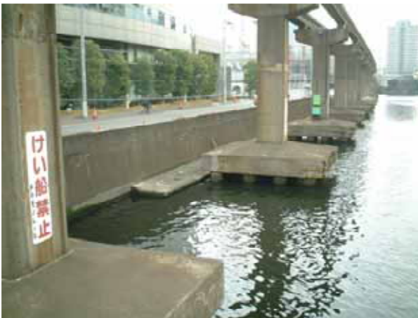
写真-2 整備前の直立護岸
