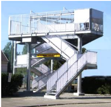
図 4-27 津波避難施設
