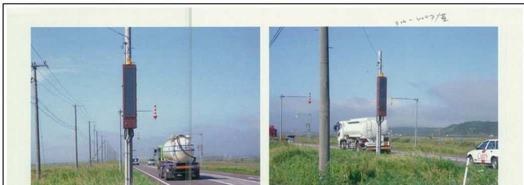
図 4-12 情報板の設置例
