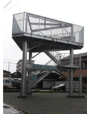
図 4-28 津波避難施設
