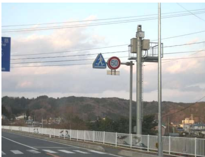
図 4-7 浸水対策型の CCTV カメラ設置例(三陸国道事務所)
