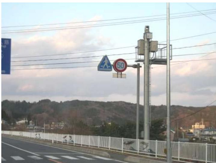
図 4-7 浸水対策型の CCTV カメラ設置例(三陸国道事務所)
