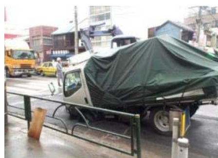
図-2 下水管路起因の道路陥没の状況
