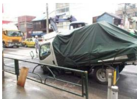
図-2 下水管路起因の道路陥没の状況
