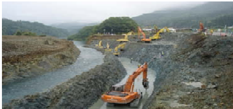
断面拡幅掘削をしながら、仮排水路を流下する磐井川
