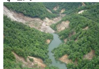
▲大規模な河道閉塞(天然ダム)
