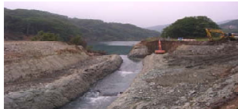
完成した断面拡幅部を流下する磐井川
