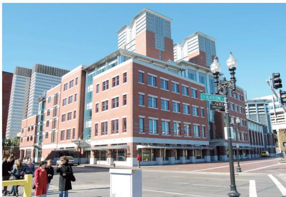
写真 2-3-2 換気塔 No.4（ボストン・ビッグディグ事業）
