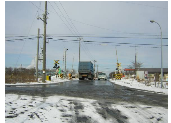
現在の踏切(海側から撮影)
