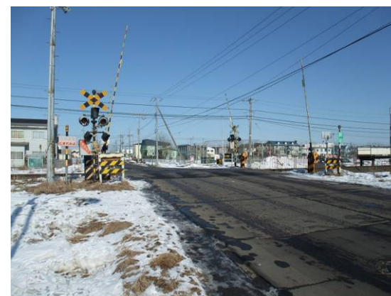
現在の踏切(海側から撮影)
