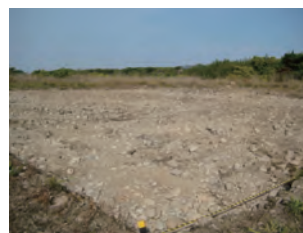
図-7 表土はぎ取り実験区（施工後）
