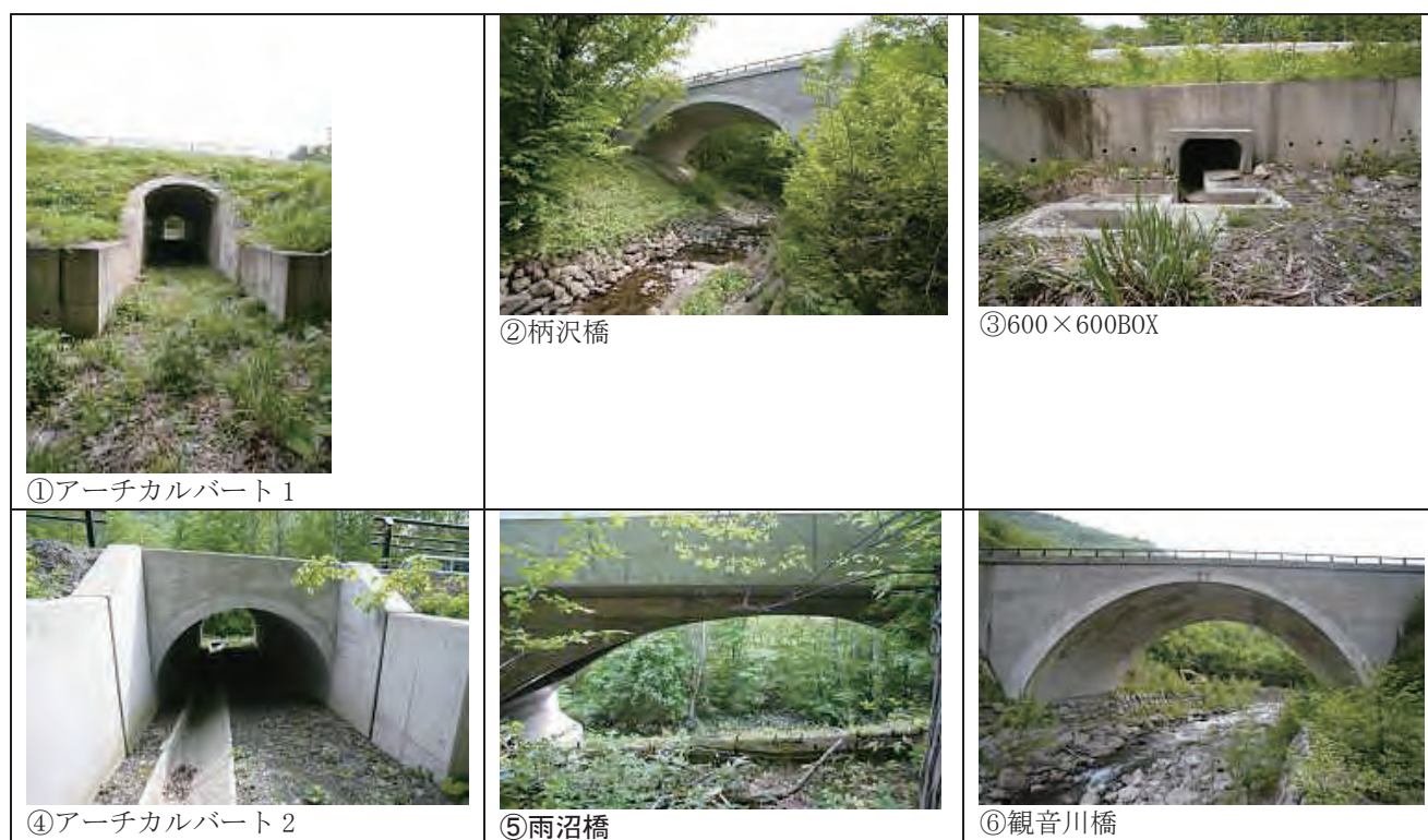
写真3 甲子道路（国土交通省直轄区間）における道路横断施設
