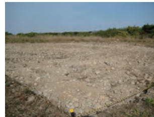
図-7 表土はぎ取り実験区（施工後）
