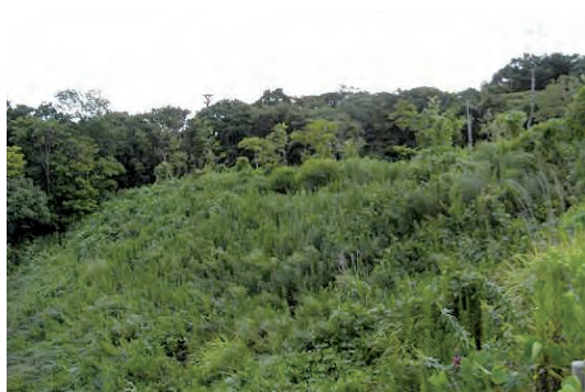
国営明石海峡公園 表土利用工
