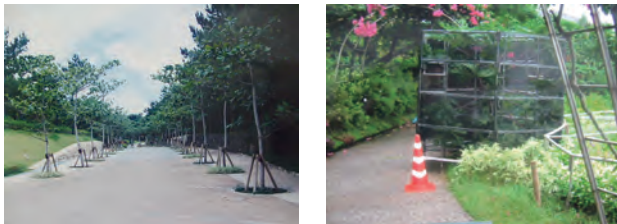
写真2 支柱等保護材の例
