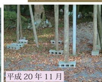
支柱基礎（ブロック）
