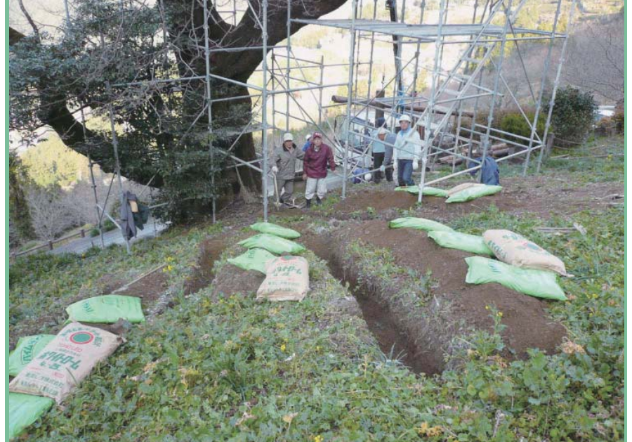
トレンチ掘削による土壌改良
