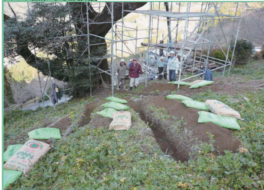
トレンチ掘削による土壌改良
