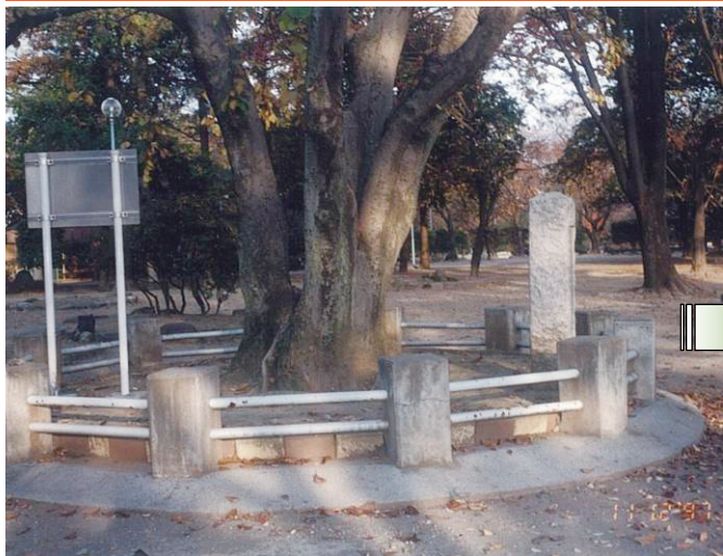
▲植栽基盤整備（植栽基盤の拡張）
