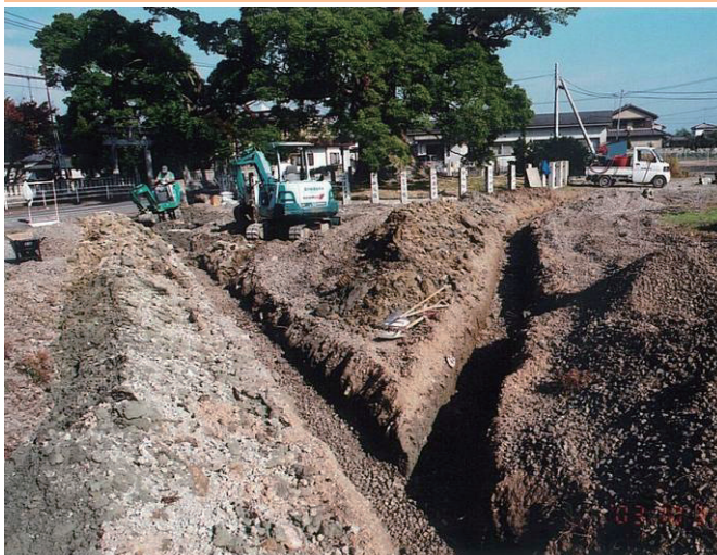
▲植栽基盤整備（排水工／暗渠排水）
