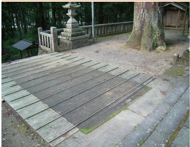
▲保護材等の整備（土壌踏圧防止対策／踏圧防止板）
