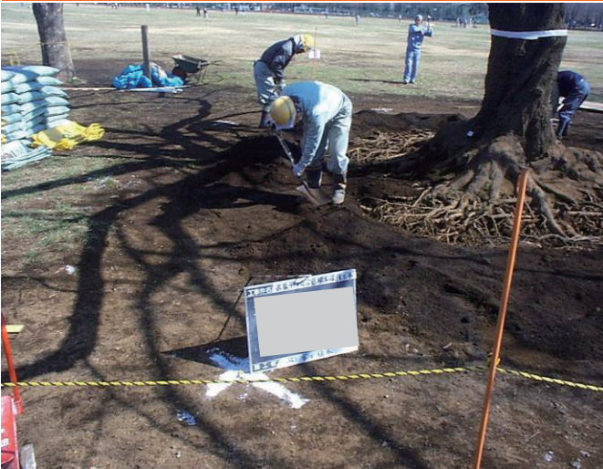
▲土壌改良（根系の露出を伴う大規模改良）
