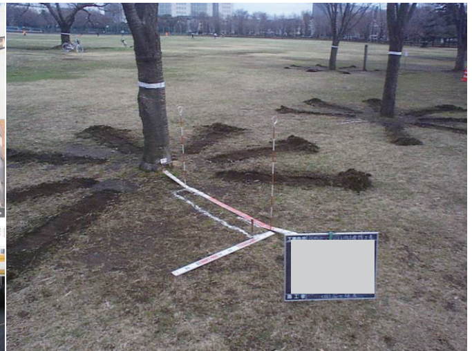
▲植栽基盤整備（土壌改良／トレンチ改良）
