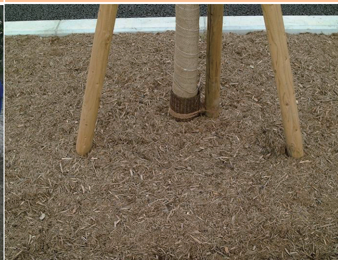
▲植栽基盤整備（マルチング）
