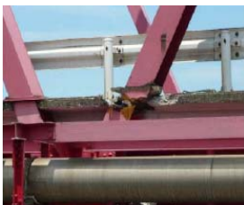
木曾川大橋 コンクリート内部の鋼材の破断
