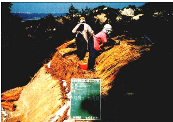
田上山腹工：当初は積苗工間ののり面処理を行っていなかったが、積苗工が土砂により埋没してしまうため、昭和35年以降はわら伏工を実施した。その結果、斜面が安定し植栽木が正常に成長するようになった。
