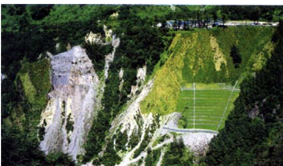
水谷山腹工：山腹基礎工の形式を斜面勾配により使い分けている。
