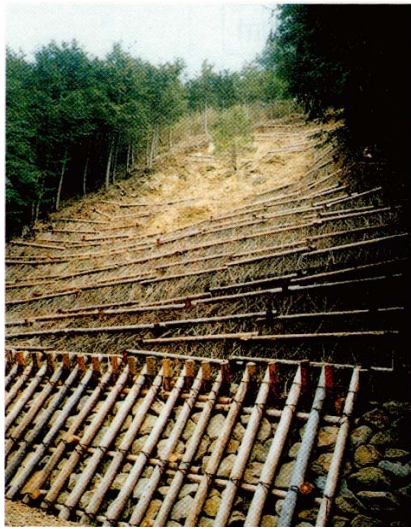
土屋原山腹工：平成元年施工時の状況
