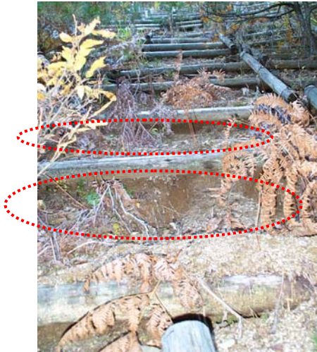
土屋原山腹工：表流水により山腹基礎工の下面が洗掘され浮いた状態となり、土砂移動が発生している。その結果植生の回復が遅れている。 ※現在は対策済み
