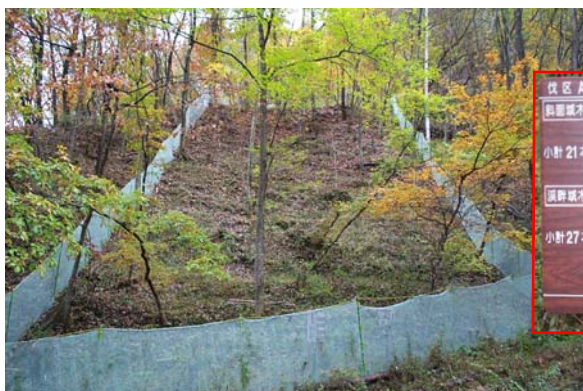
水谷山腹工斜面上部：全体的に初期導入植物種の本ハギ、ヤマハギ、イタチハギの繁茂が目立ち、実施後10年以上が経過するが顕著な植生遷移は見られない。
