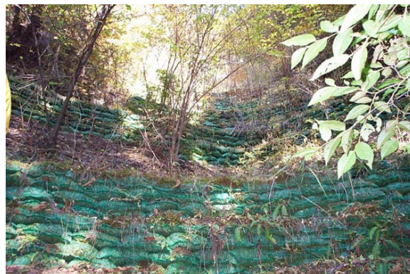
土屋原山腹工：土のうの使用例
