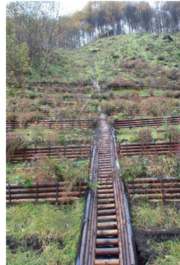
野麦峠山腹工：土屋原山腹工と同様に山腹基礎工に間伐材を使用したのが、表流水や伏流水の処理が適切に行われており、洗掘等は確認されていない。
