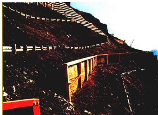
大難山腹工：土留工で風等により移動しやすいスコリアを確実に固定している。
