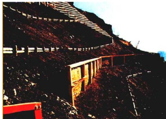
大薙山腹工：土留工で風等により移動しやすいスコリアを確実に固定している。
