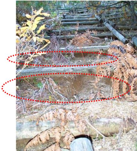
土屋原山腹工：表流水により山腹基礎工の下面が洗掘され浮いた状態となり、土砂移動が発生している。その結果植生の回復が遅れている。
