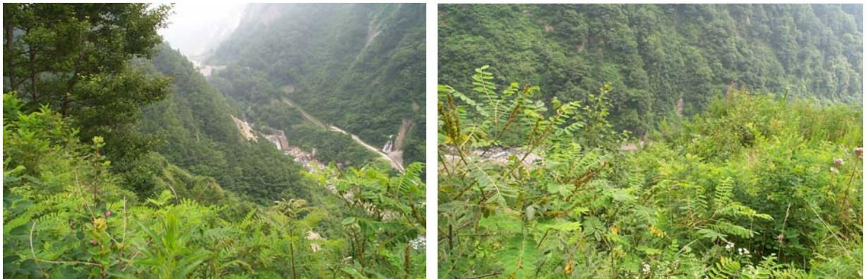
水谷山腹工斜面上部：全体的に初期導入植物種のメドハギ、ヤマハギ、イタチハギの繁茂が目立ち、実施後10年以上が経過するが顕著な植生遷移は見られない。
