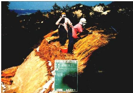
田上山腹工：当初は積苗工間のり面処理を行っていなかったが、積苗工が土砂により埋没してしまうため、昭和 35 年以降はわら伏工を実施した。その結果、斜面が安定し植栽木が正常に成長するようになった。
