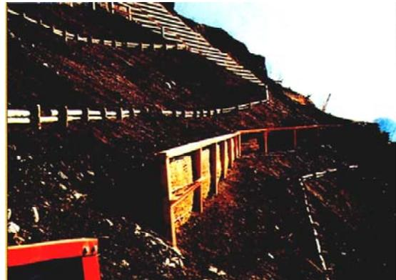
大難山腹工：土留工で風等により移動しやすいスコリアを確実に固定している。
