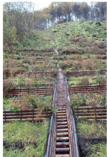
野麦峠山腹工：土屋原山腹工と同様に山腹基礎工に間伐材を使用したが、表流水や伏流水の処理が適切に行われており、洗掘等は確認されていない。
