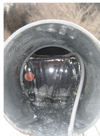
写真－2 堰部の流水状況(ケース 4)
