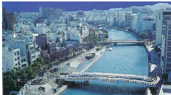
新町川及び新町川水際公園全景 (左側が新町川水際公園)
