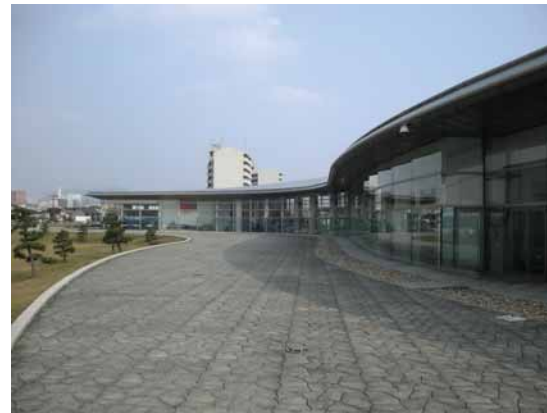
美術館前の園路 舗装部分の園路は、湖側が河川管理用通路となっている。
