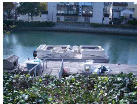
②NPOが運営するひょうたん島クルーズ乗船場 河川占用により浮棧橋設置
