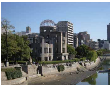
元安川からの原爆ドームの景観
