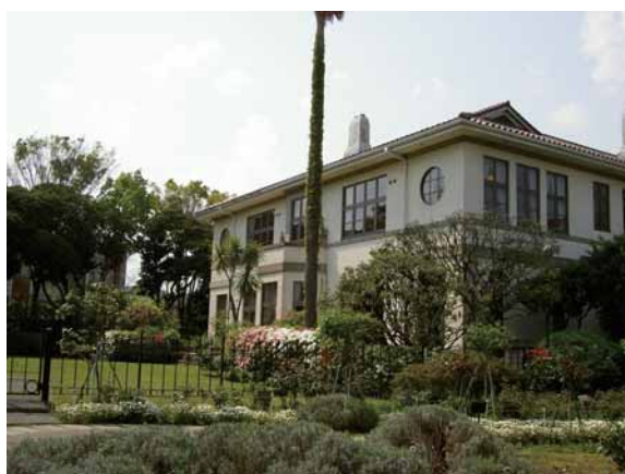
イギリス館 公園内の既存建築物を歴史的建造物として保存し、活用している。
