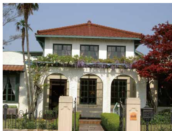
旧山手 111 番館 公園区域の拡張により保存しているため、たたずまいがそのまま保存され、活用されている。
