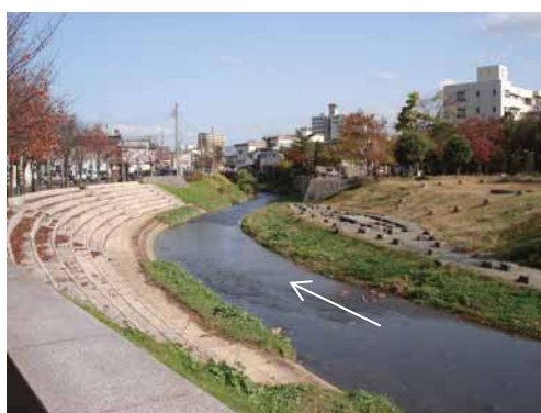
上流側から見た景観 右側 (右岸側) が公園区域。左側 (左岸側) は、河川管理者が公園整備と一体的に河川整備を行った階段護岸、遊歩道、植栽。
