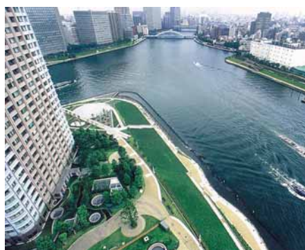
公園北端部俯瞰 緩傾斜堤防上に整備された公園は、住棟まわりの公開空地と境界線だけで境のない一体的な整備をしている。 写真)公園パンフレット
